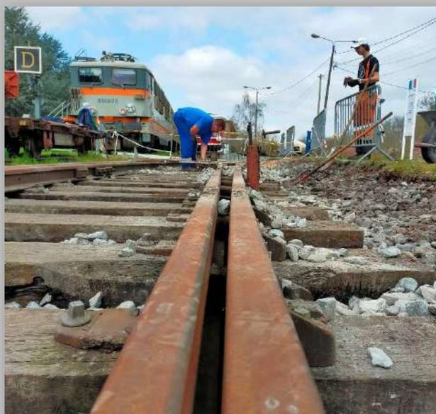
Les écartements, niveaux et alignements sont vérifiés avec précision, avant de poursuivre la seconde partie de l'aiguillage :
