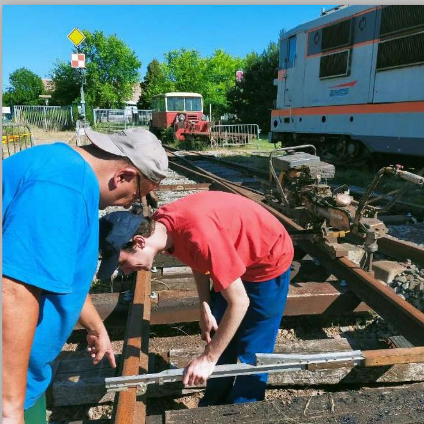
L'aiguillage étant entièrement ballasté, nous nous attaquons à l'aiguillage dont les bois ont subi les ravages du temps et ne sont plus conformes pour nous permettre les manœuvres nécessaires au futur transfert de la rame HBNPC.
