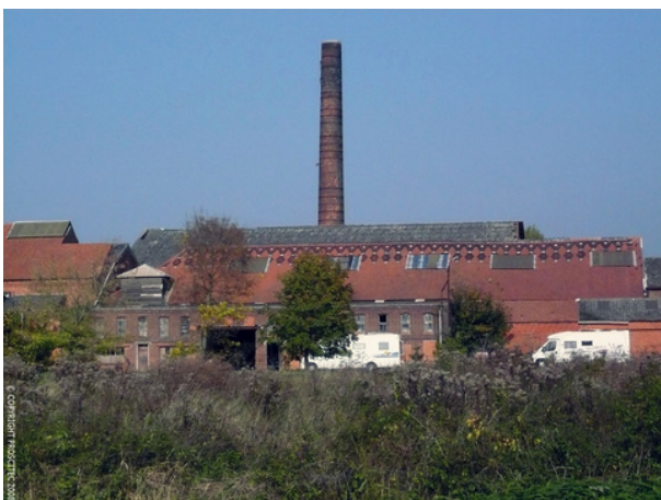
Cheminée de la briqueterie à Râches avant sa rénovation, photographie prise le 16/10/2007 © PROSCITEC.
