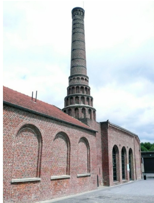
Cheminée du MTVS à Fourmies, photographie prise le 30/05/2007 © PROSCITEC.
