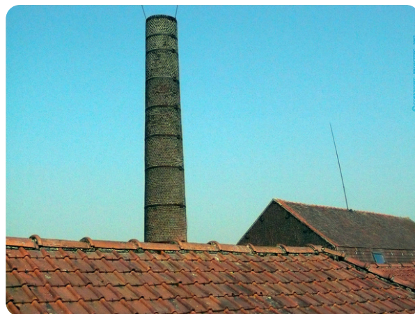
Cheminée de l'usine Piron à Godewaersvelde avant sa rénovation, photographie prise le 22/02/2007 © PROSCITEC.
