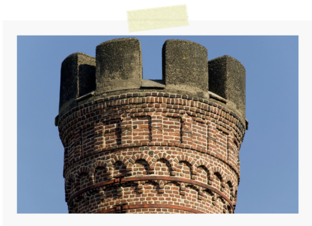
Sommet crénelé de l'usine Motte-Bossut à Roubaix, photographie prise le 08/02/2008 © PROCISTEC.
