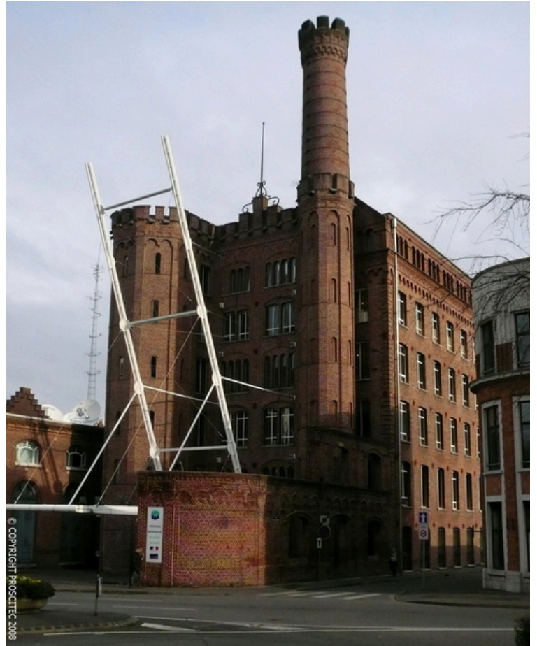
Cheminée des Archives Nationales du Monde du Travail à Roubaix, photographie prise le 08/02/2008 © PROSCITEC.
