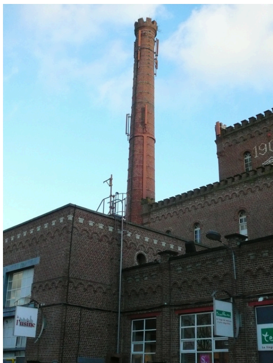
Cheminée de l'Usine de Roubaix Avenue Alfred Motte avant sa rénovation, photographie prise le 23/01/2008 © PROSCITEC.
