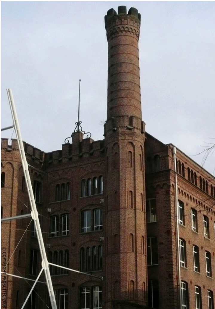
Cheminée des Archives Nationales du Monde du Travail à Roubaix, photographie prise le 08/02/2008 © PROSCITEC.
