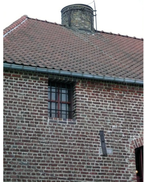
Cheminée du Musée de la Cour des potiers à Ferrière-la-Petite, photographie prise le 11/05/2007 © PROSCITEC.
